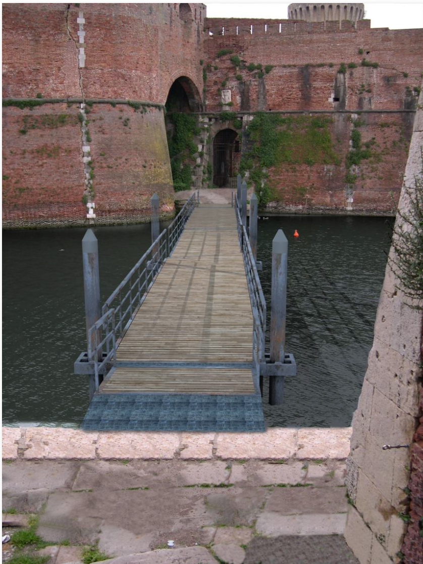
ponte girevole chiuso
